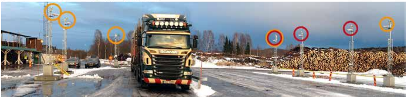
Bildmätning – installation vid SCA:s terminal i Töva, Sundsvall.
