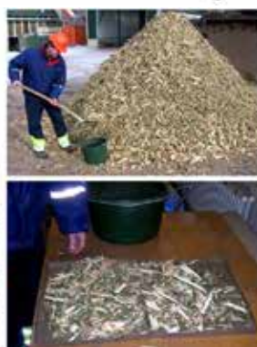
Vid Jämkraft i Östersund tillämpas stickprovssystem för att bestämma torrhalten på grot. För alla leveranser bedöms torrhalten. Detta görs med hjälp av foton. Slumpmässigt valda travar/skäppor flisas varefter torrhaltsprov tas ur flisen.
