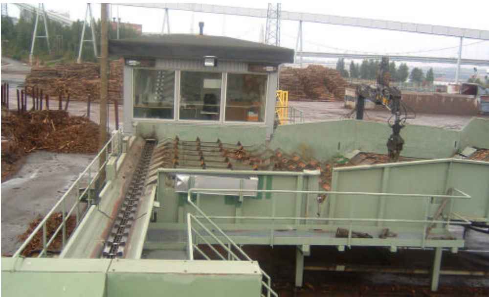
Figur 2. Sunila, bedömningsbord samt hus för virkesmätare/operatör.
